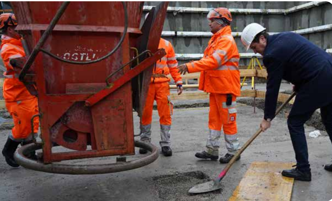
Der Spatenstich beim Investitionsprojekt Schulhaus Wolfsmatt erfolgte 2025.
