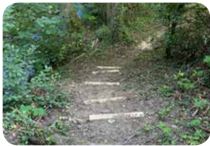
Der Brüggliweg wurde provisorisch neu erschlossen.
