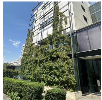
Beispiel Flurstrasse Zürich Fassadenbegrünung im Zentrumsgebiet Quelle: SPA Dietikon
