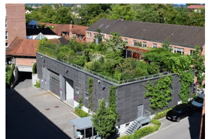
Beispiel Intensive Dachbegrünung Quelle: Bundesverband GebäudeGrün e.V.
