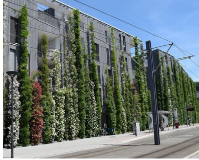
Beispiel Freiburg Fassadenbegrünung im Zentrumsgebiet Quelle: Bundesverband GebäudeGrün e.V.
