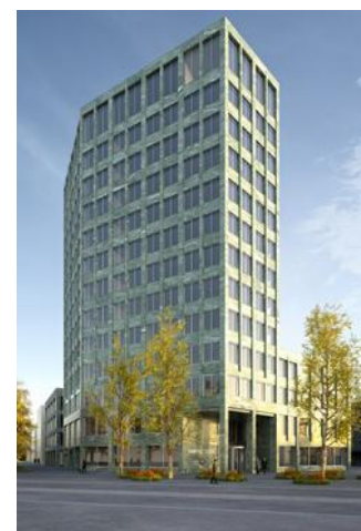
Referenzbeispiel: Raumbildendes Hochhaus als Quartiermerkpunkt am Gaisplatz in Aarau (Projekt: Schneider Schneider Architekten)
