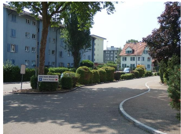
Gjuchstrasse: Ineffiziente Erschliessung (Bild: Van de Wetering)
