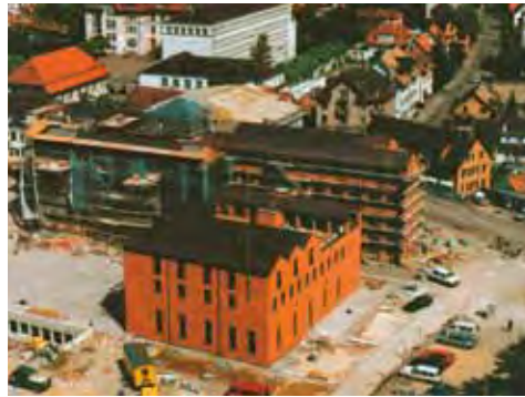
Das neue Stadthaus während der Bauphase.
