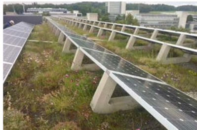
Bild Stadt Zürich, Dachbegrünung mit Solaranlage
