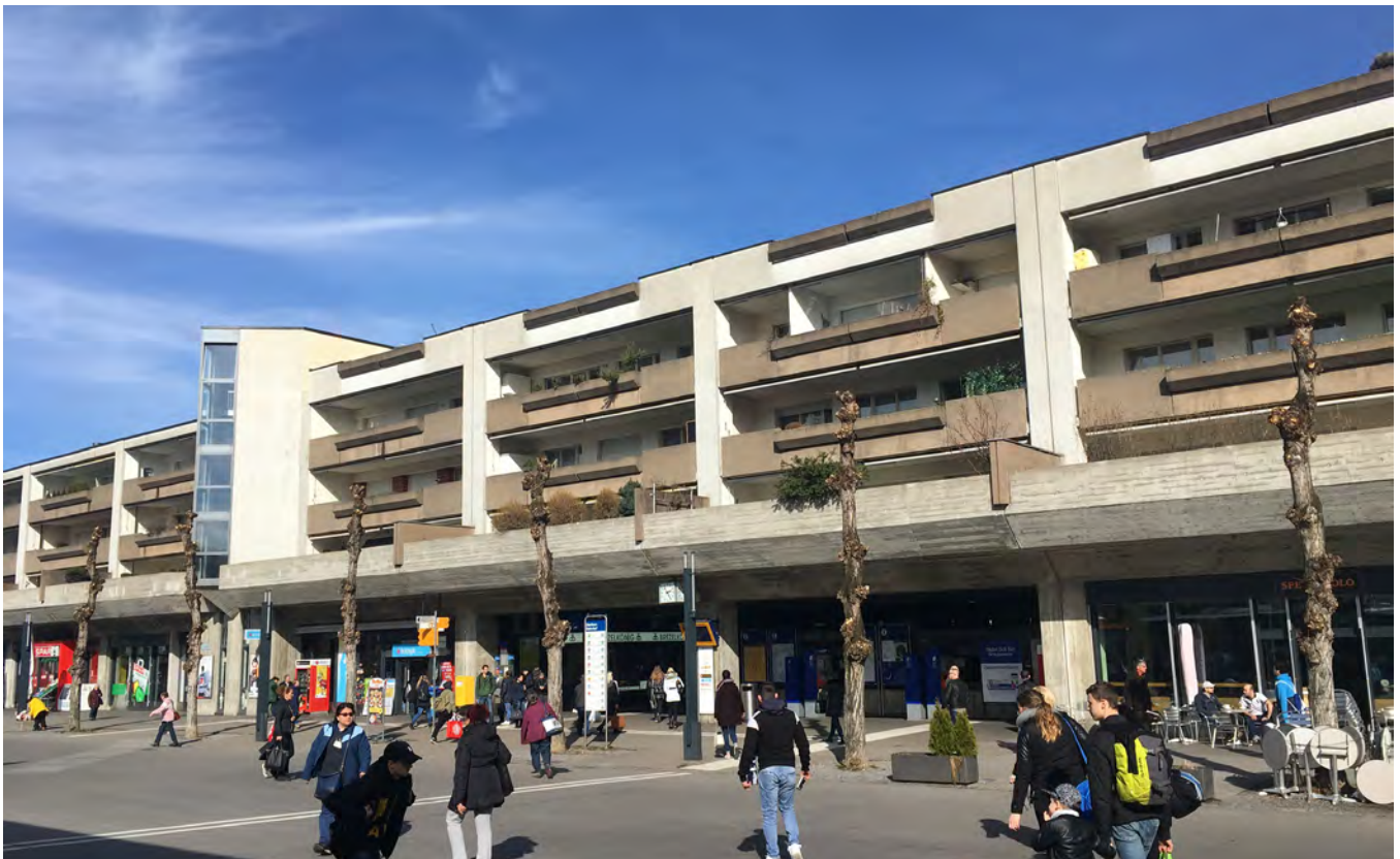
Abb. 4: Aufnahmegebäude Bahnhof Dietikon (Eckhaus | 02.03.2017)
