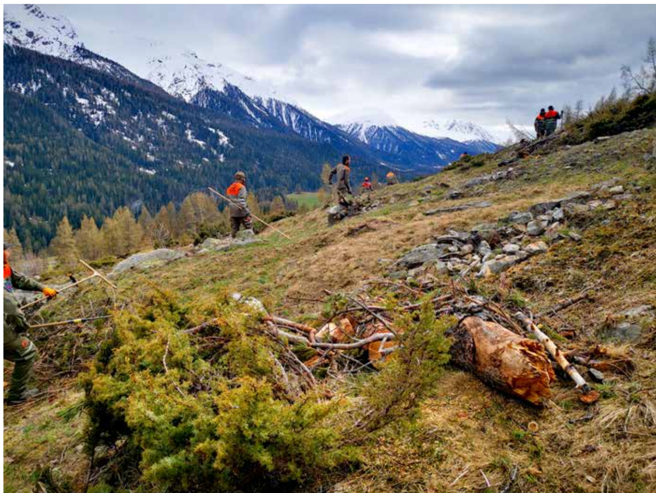
Die Zivilschutzorganisation Region Dietikon half im Kanton Graubünden bei Instandstellungsarbeiten.
