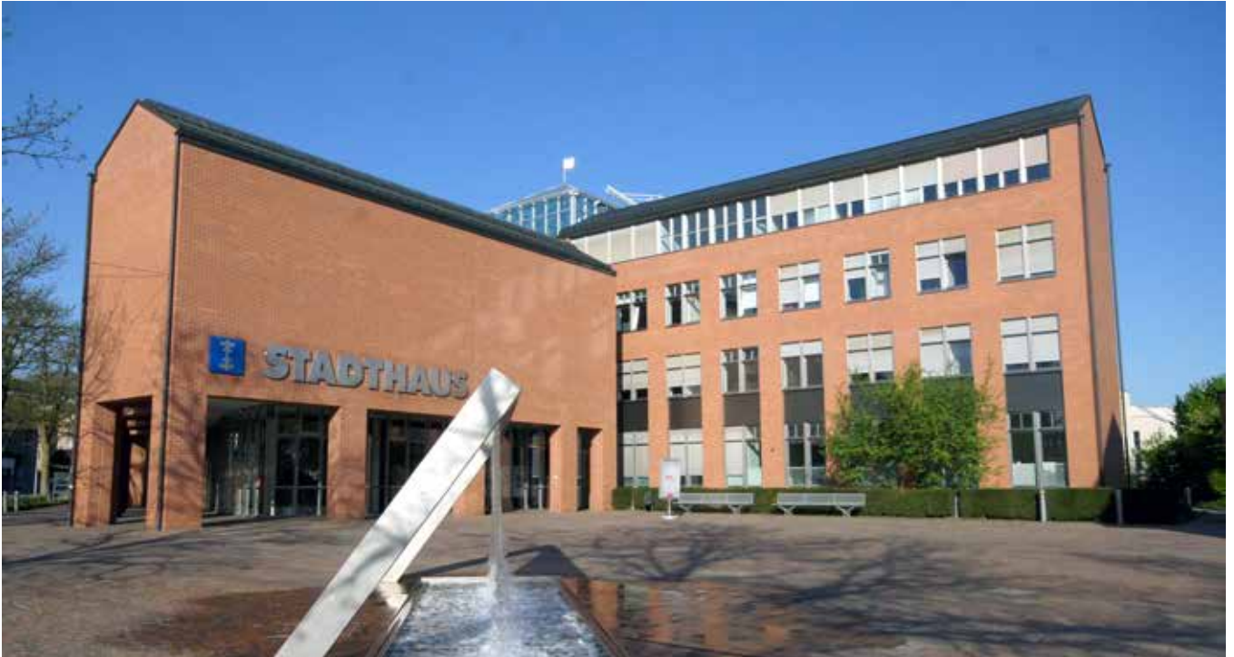
Das Stadhaus wird zu klein, ein Stadthaus II soll Kapazitätsengpässe beheben.
