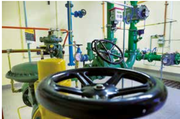
Druckreduzier- und Messstation: Druck wird von Hochdruck-Transportleitung auf das Niederdruck-Verteilnetz reduziert.
