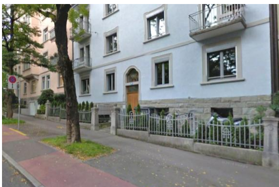
Referenzbeispiel Kornhausstrasse, Zürich: stark durchgrüner Boulevard mit urbanem Charakter; klare Adressbildung, Vielseitigkeit, Raumbildung (Bild: Google)
