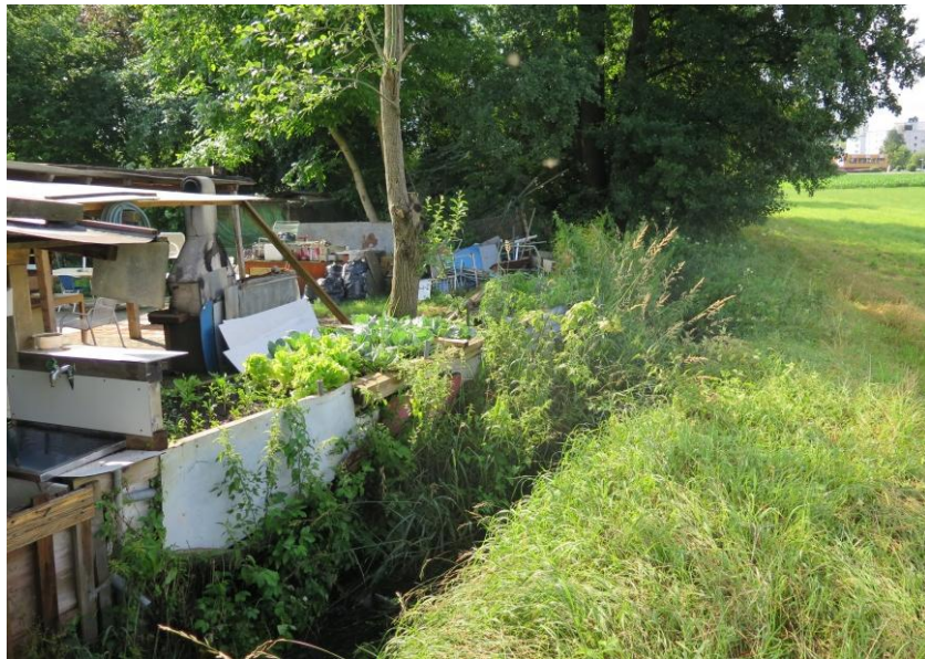
Abb. 11 Naturferner Böschungsverbau entlang der Schrebergärten
