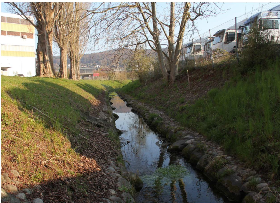
Gerinne Teischlibach unterhalb des SBB-Durchlasses (km 0.49), Blick in Fliessrichtung
