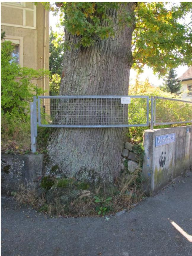
**Foto 3:** Strassenseitige beengte Wurzelanläufe mit Schäden durch Schneeräumungsfahrzeuge.
